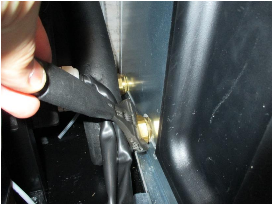
Steg 18. Demontera undre köldbäraranslutning.
