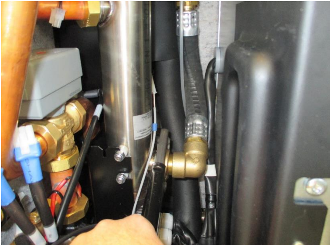
Steg 20. Demontera anslutning för inkommande värmebärare till elpatronen. Ta bort slang.
