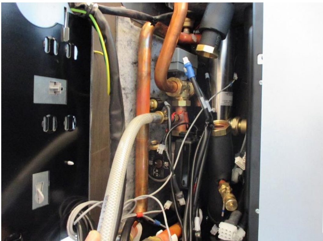
Steg 16. Töm värmebäraren genom avtappningskran, 1/2" anslutning.
