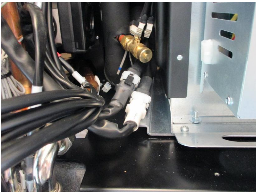
Steg 15. Demontera 2 st elanslutningar till elpatronen.
