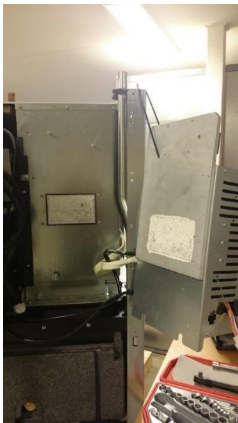
Steg 12. Montera invertern i höger sidostolpe.
