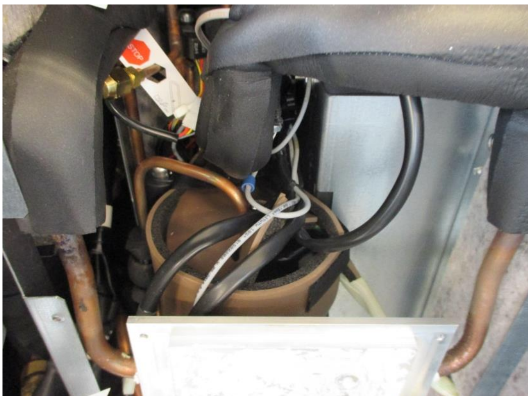
Steg 15. Demontera toppisoleringen på kompressorn och öppna upp kardborrefästet på sidan. Skruva bort 2 st M5 muttrar för plastlocket till kompressorns elanslutningar.
