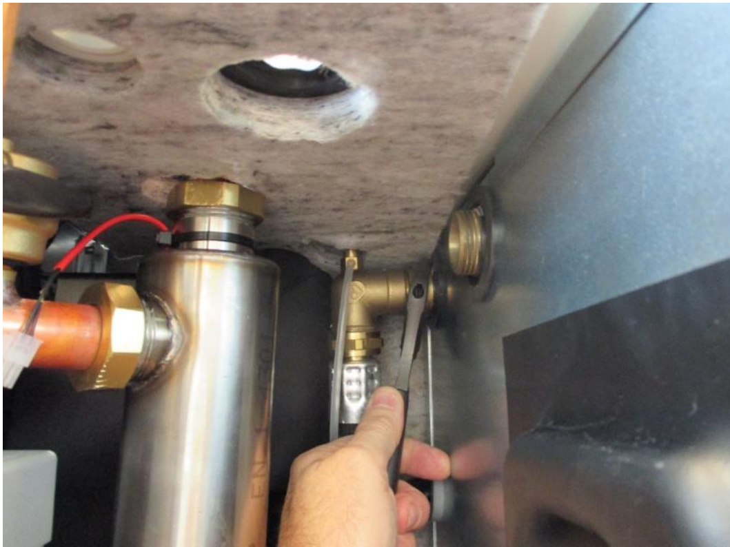
Steg 19. Demontera övre värmebäraranslutning.
