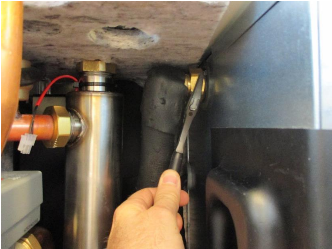
Steg 17. Demontera övre köldbäraranslutning. Ta bort slang genom att dra den nedåt.
