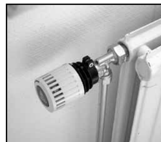
Öppna termostatventilerna helt.
