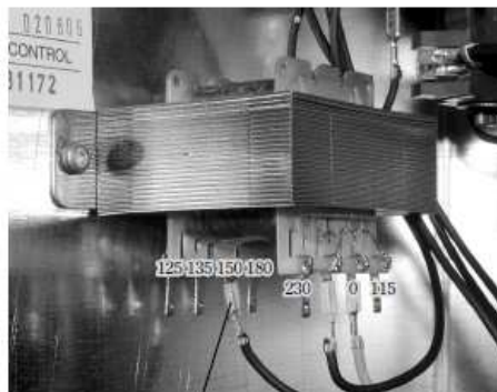
Denna kabel flyttas.
