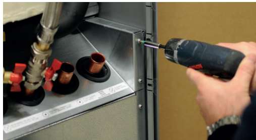
3. Avlägsna kylmodulens fästskruvar.
