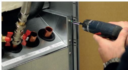
3. Avlägsna kylmodulens fästskruvar.
