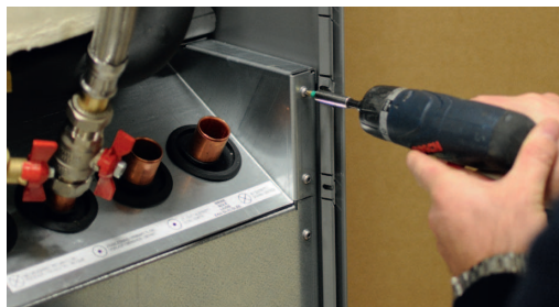
3. Avlägsna kylmodulens fästskruvar.
