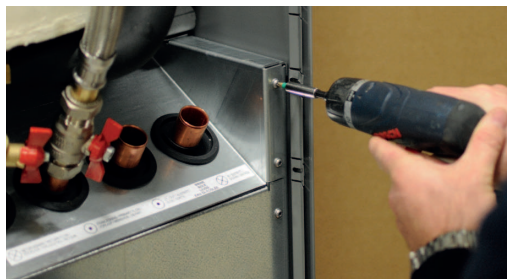
3. Avlägsna kylmodulens fästskruvar.
