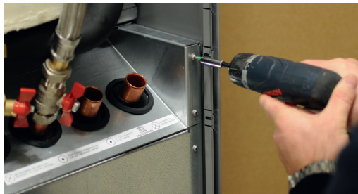
3. Avlägsna kylmodulens fästskruvar.
